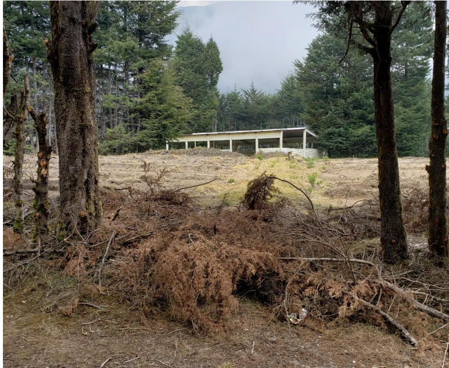
Figura 30. Zona de campamento techada para 20 personas aproximadamente
