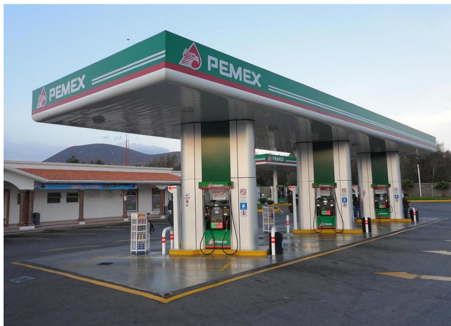
Figura 17.- Gasolinera El Tephé
