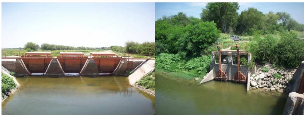
Figura 40. Estructuras de Operación en el Distrito de Riego 026 Bajo Río San Juan
