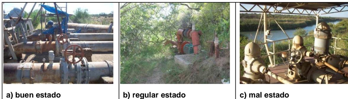
Figura 61. Estado físico bueno, regular y malo de los sistemas de bombeo del Distrito de Riego 050 Acuña Falcón, Tamaulipas.
