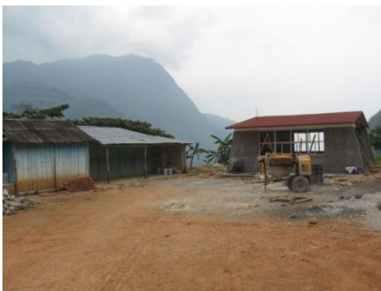
Figura 23. Escuela en construcción, comunidad Unión y Progreso, Municipio Eloxochitlan.
