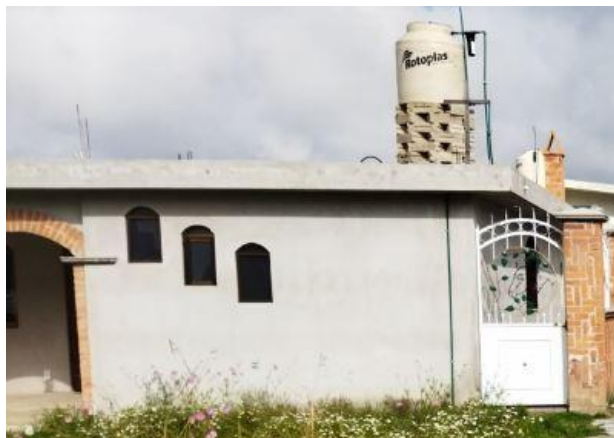
Figura 9. Vivienda construida convencionalmente en Tlaxco, Tlaxcala.
