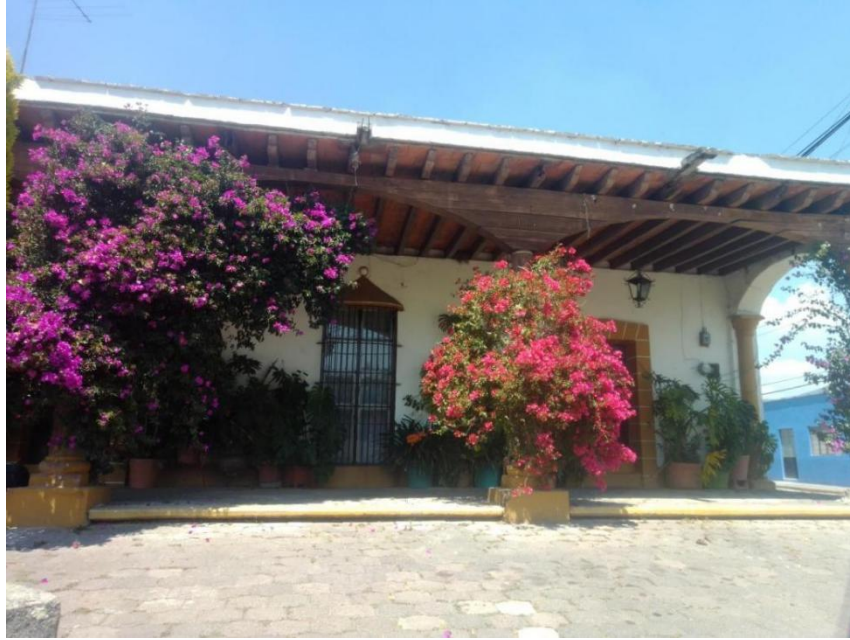
Figura 20. Casa de Tlaxco, Tlaxcala cercana al centro, donde se observa el uso de madera en la estructura de techos
