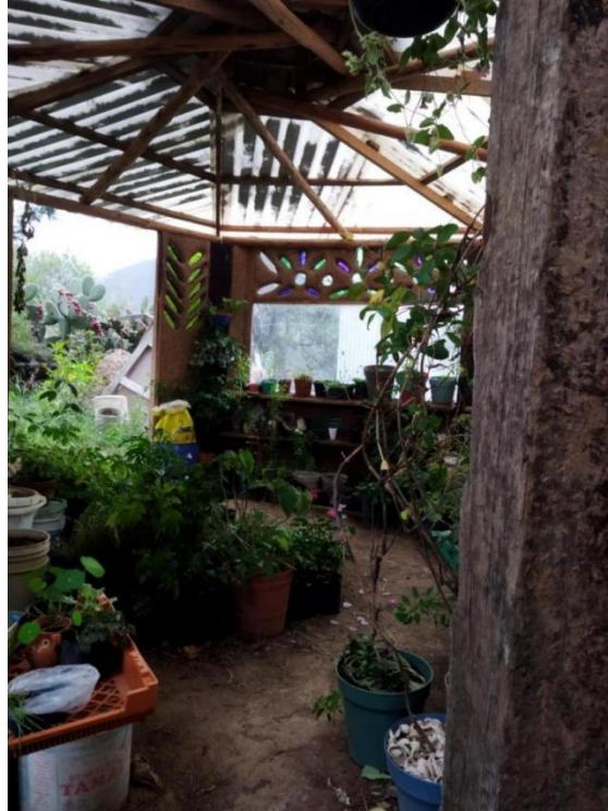
Figura 22. Invernadero de un entrevistado donde se aprecia el uso de madera y barro para su construcción en Tlaxco, Tlaxcala.
