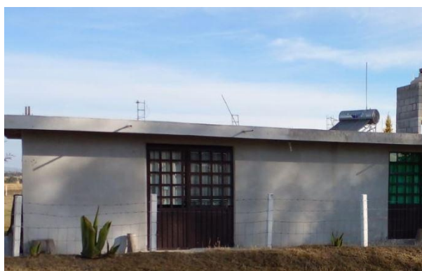
Figura 11. Vivienda construida convencionalmente en Tlaxco, Tlaxcala.
