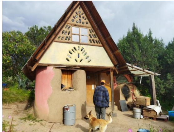
Figura 6. Vivienda de dos niveles bioconstruida en Tlaxco, Tlaxcala
