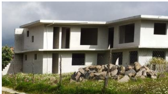
Figura 7. Vivienda de dos niveles convencional en Tlaxco, Tlaxcala
