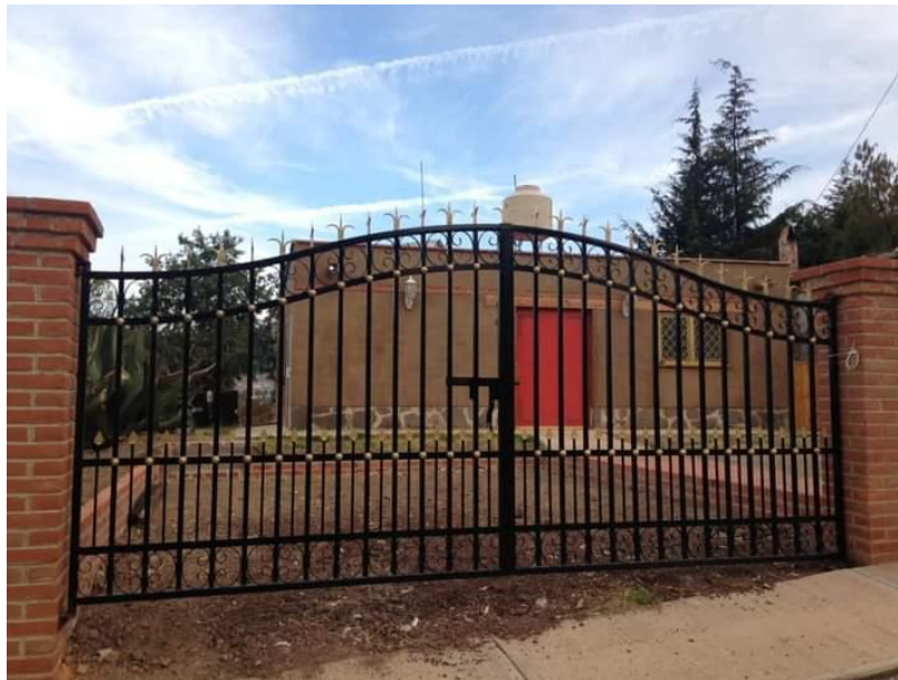
Figura 21. Vivienda entrevistada, construida con adobe, piedra y cal fermentada entre otros materiales naturales en Tlaxco, Tlaxcala.
