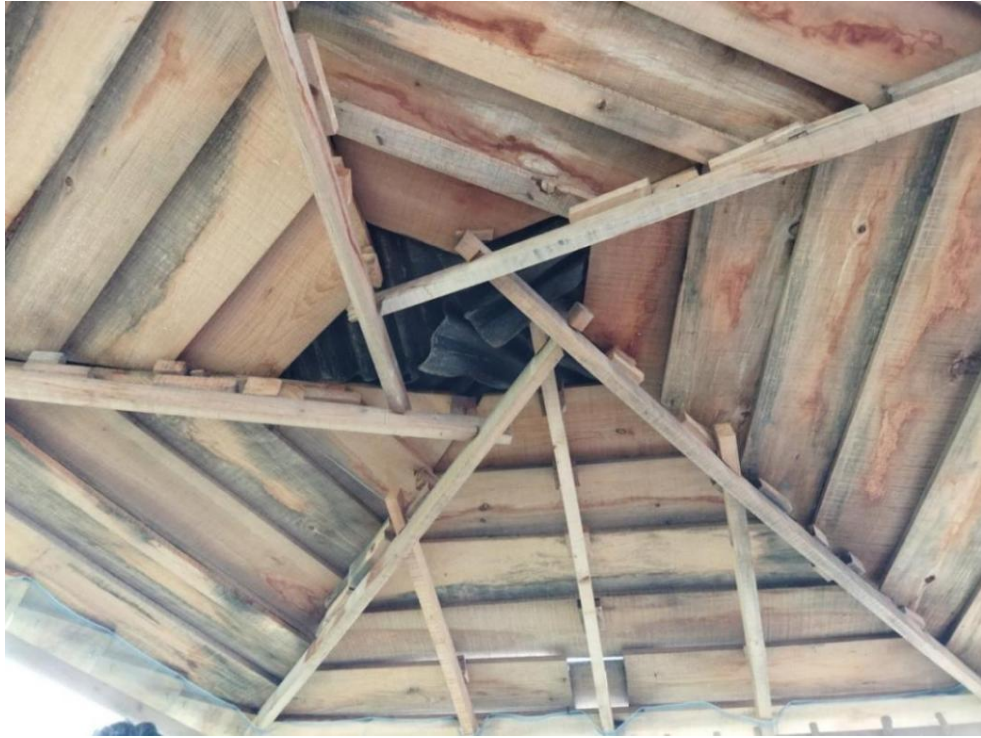
Figura 26. Techo autoportante construido por los usuarios entrevistados en Tlaxco, Tlaxcala.
