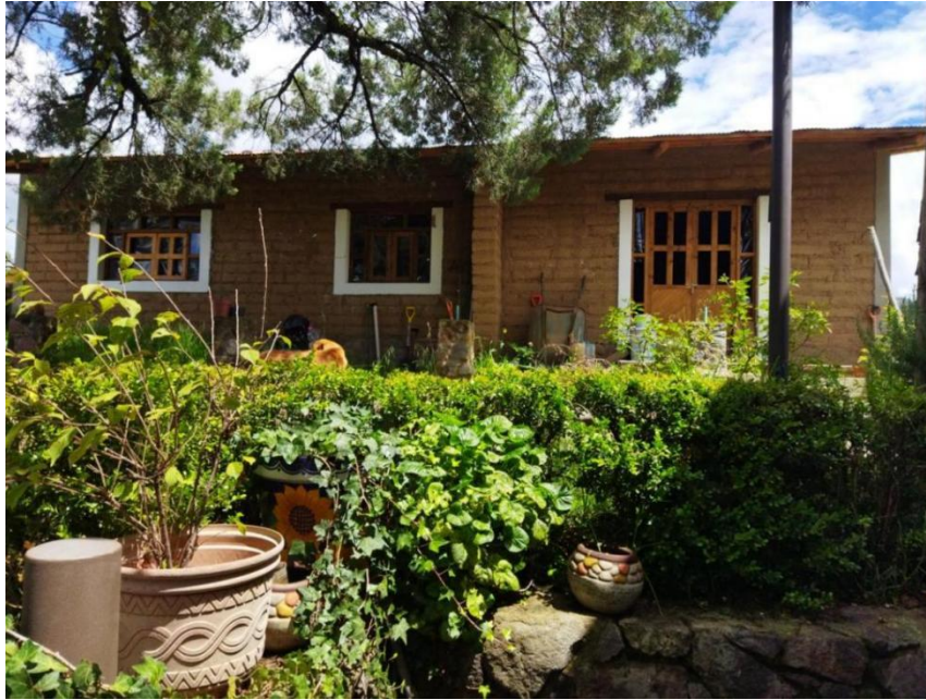
Figura 24. Una de las estructuras de una de las viviendas entrevistadas que uso bioconstrucción para su levantamiento en Tlaxco, Tlaxcala.
