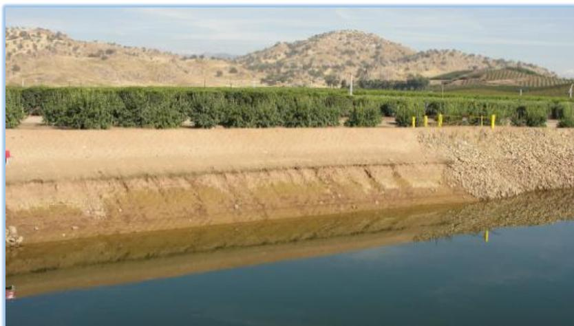
**Figura 10. Sección tratada con cal del canal Friant-Kern (tomada en noviembre de 2010) en la parte izquierda; la parte derecha consiste en una pendiente original no tratada cubierta de grava. Fuente: Herrier *et al.*, (2013)**
