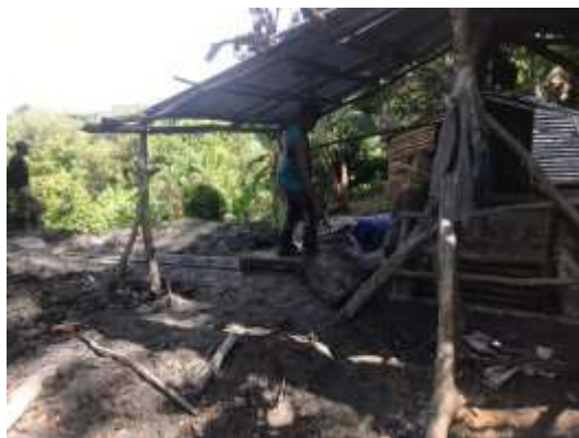
Fotografía 28. Corte vertical a la entrada de la mina en La Cumbre, República Dominicana.
