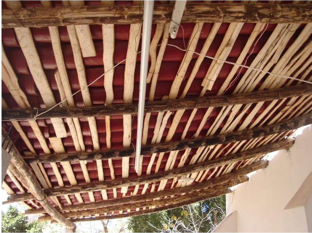
Figura 20. Techo construido con quiotes de Agave scaposa
