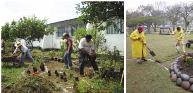
Figura 25. Excavación y remoción del suelo.
