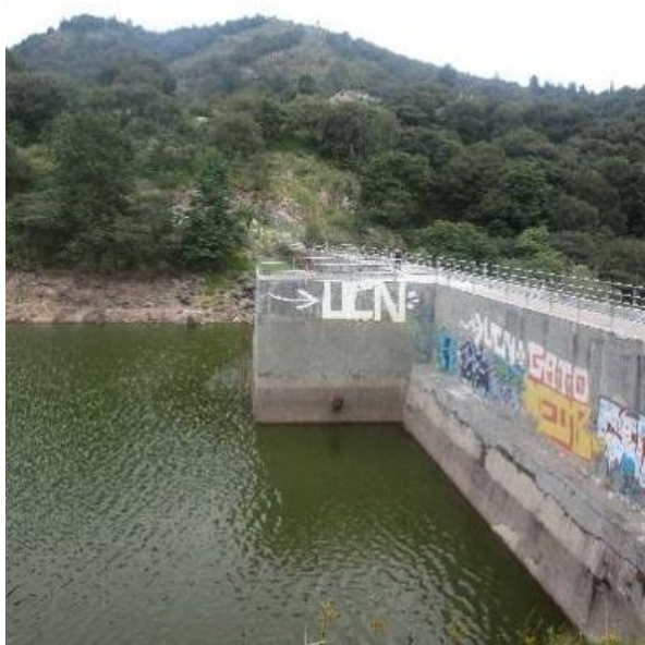
Foto 1.- Presa El Jaramillo, Mineral del Monte.
