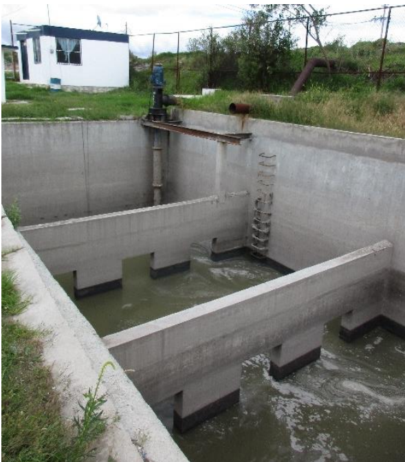
Foto 6.- Cárcamo de Tuzos, foto tomada en Trabajo de campo, 2018.
