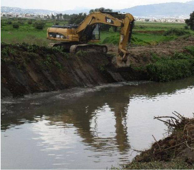
Foto 9.- Trabajos de limpieza del cauce del río de las Avenidas foto tomada en trabajo de campo, 2018.
