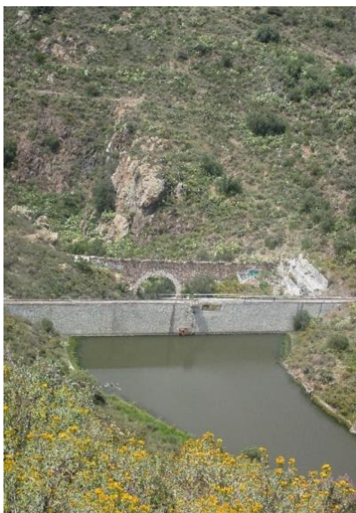
Foto 2.- Presa las Avenidas, Pachuca de Soto.
