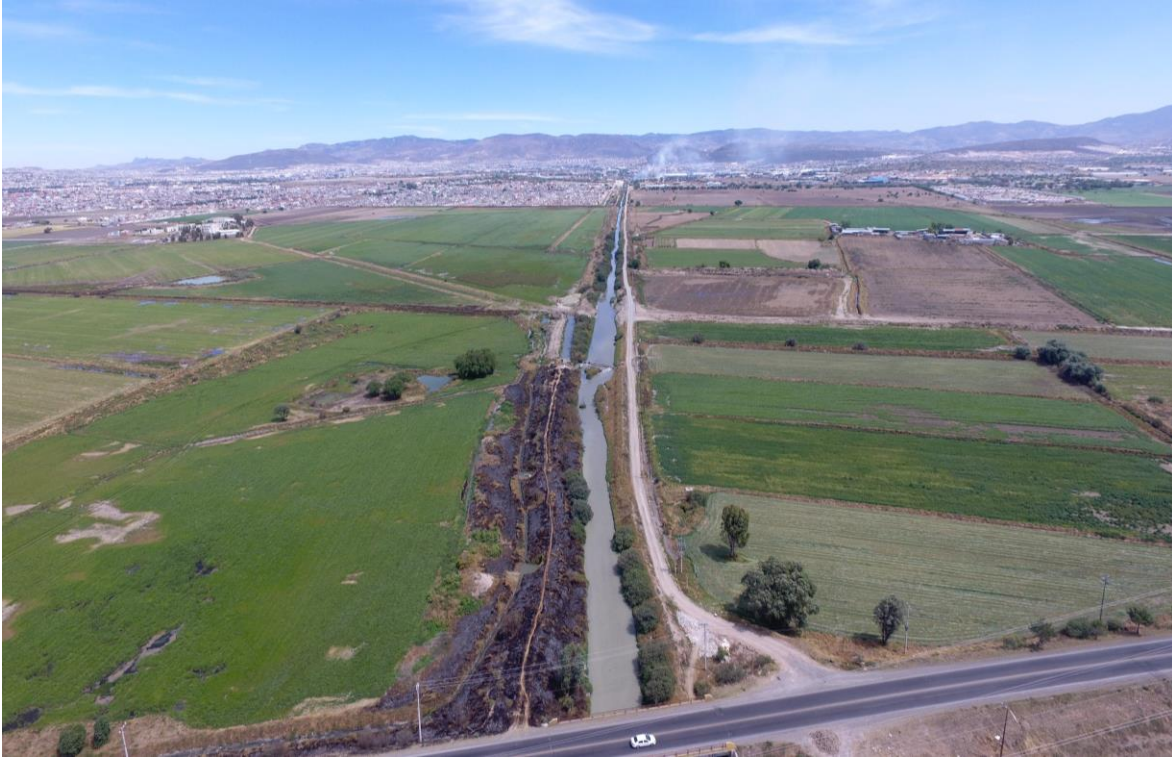
Foto 11.- Cauce del río de las Avenidas en la periferia de la ciudad de Pachuca
