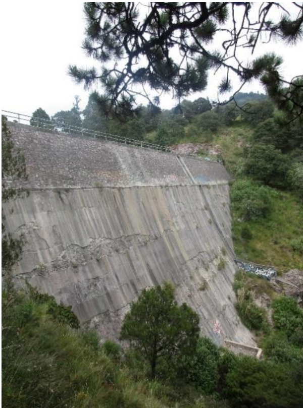
Foto 4.- Cortina de la presa El Jaramillo, Mineral del Monte, Hidalgo.
