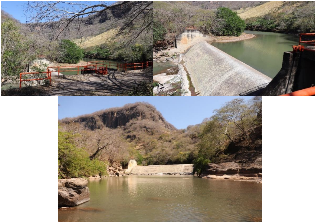
Figura 9. Presa de derivación Cajones, ubicada en Los Cajones Michoacán
