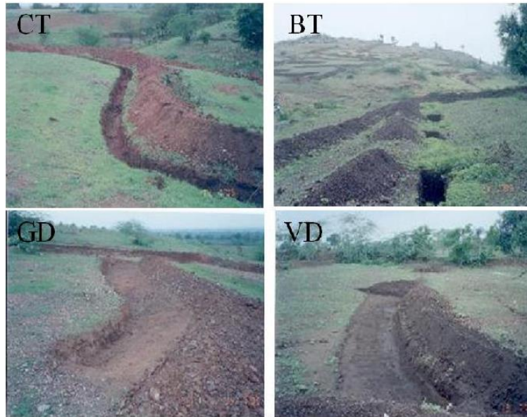
Figura 2. Obras de recolección de agua de lluvia en colinas degradadas, Rajastán, India.
