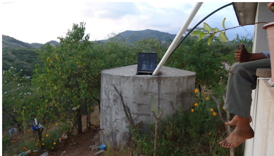
CISTERNA DE FERROCEMENTO Y HUERTO PESA
