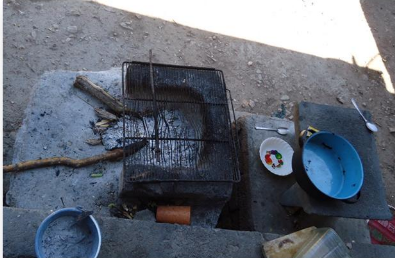
FOGÓN EN FORMA DE “U” DE BLOQUES
