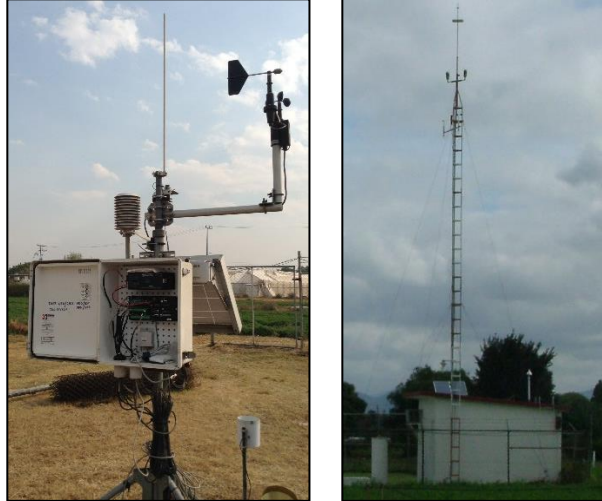
Figura 6.1. Sensores de velocidad de viento de la EMA y de la SEDEMA instalados en el Colegio de Postgraduados
