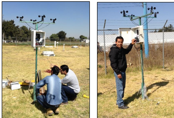
Figura 6.6. Instalación de anemómetros a una misma altura para su calibración
