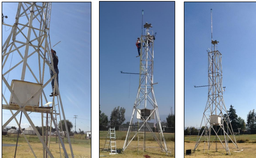
Figura 6.8. Instalación de anemómetros a diferentes alturas
