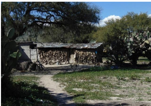
Figura 10. Construcción de jacal con pencas de maguey, San Andrés Daboxtha, noviembre de 2015 (fotografía del autor).
