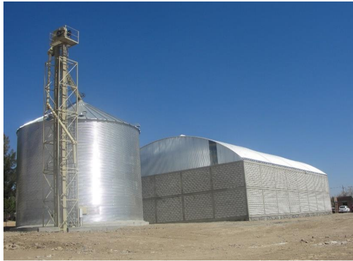
Figura 3.4. Silo metálico y bodega en Atzitzihuacán. Fuente: propia capturada durante recorrido.
