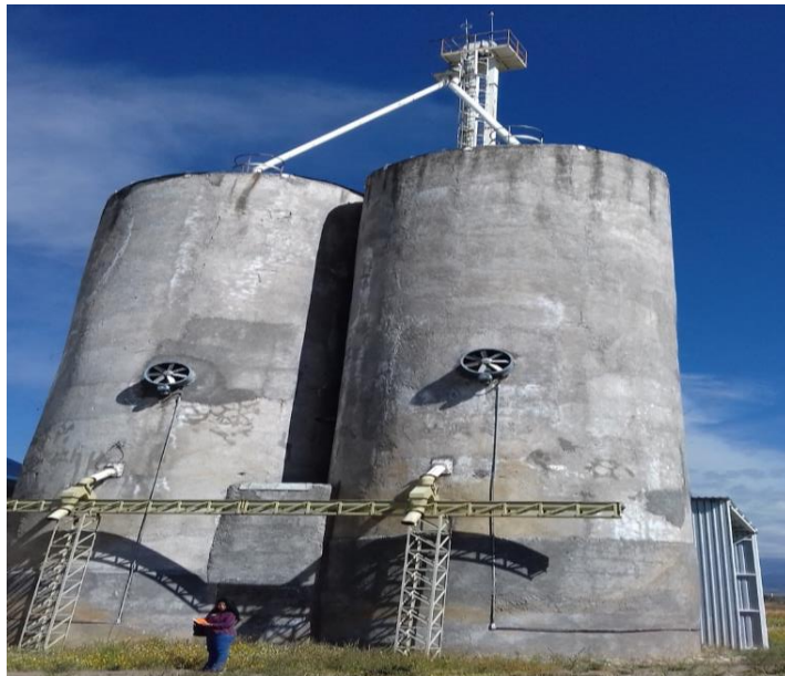
Figura 3.5. Silos de concreto en Acteopan. Fuente: propia capturadas durante recorrido.
