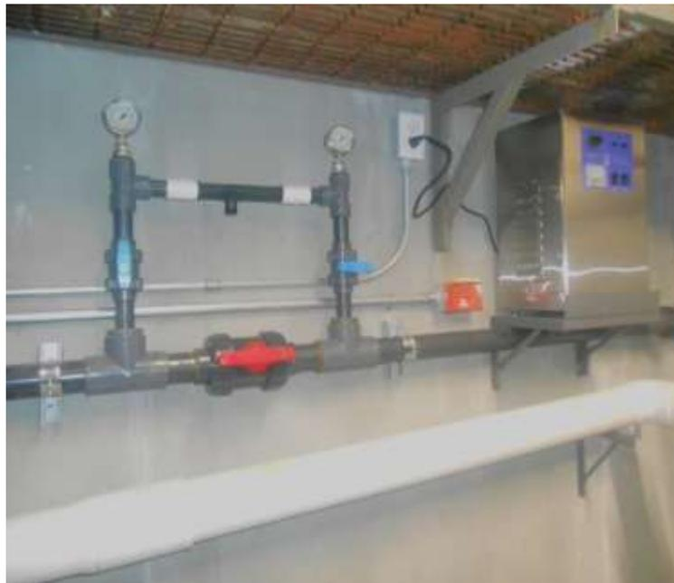
Figura 48 Sistema de producción e inyección de ozono.
