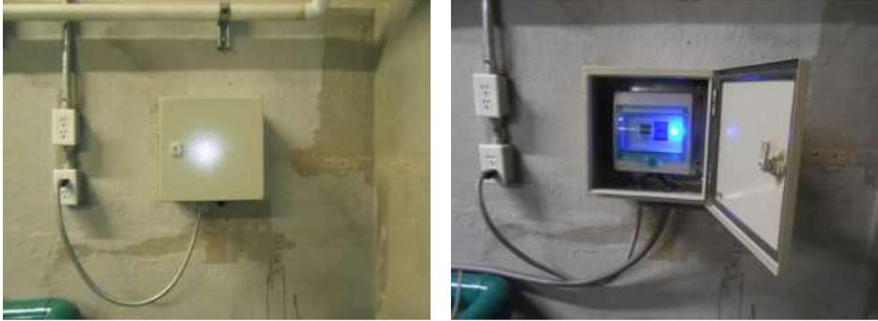
Figura 36 Caja de control del dosificador automático
