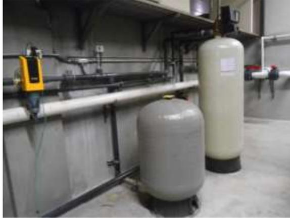
Figura 54 Tanque precargado de 62 galones.
