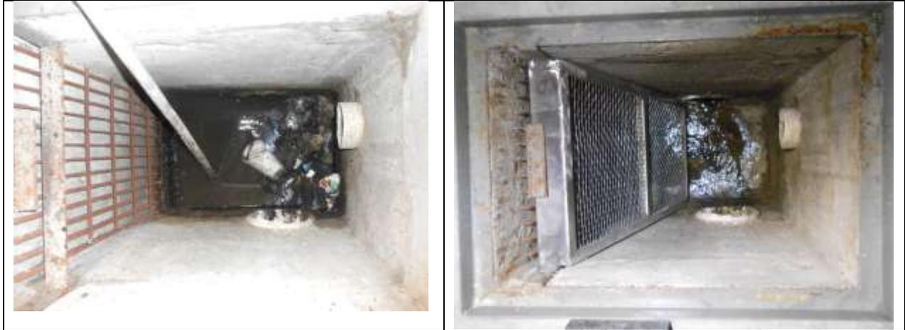
Figura 35 Registro para el control de sedimentos. Sin mantenimiento (izquierda) y con reja y mantenimiento (derecha).
