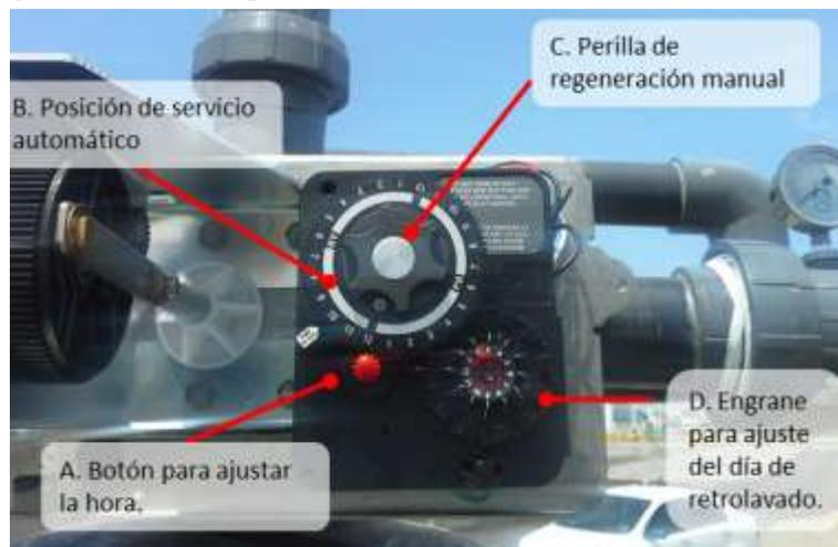
Figura 47 Componentes de la válvula fleck 2900 para el retrolavado automático por tiempo.
