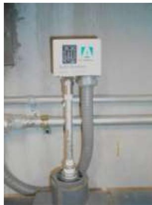
Figura 53 Presostato tipo KPI 35-38 Altamira.
