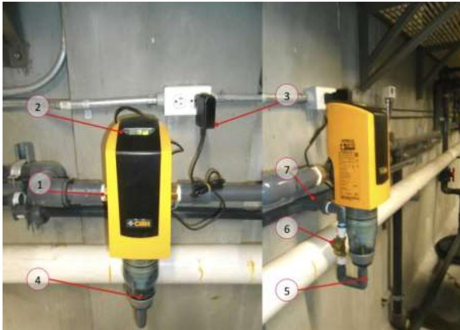
(1) Pieza de conexión de bronce orientable, (2) menu de programación y tapa de protección, (3) conector del transformador, (4) cilindro transparente con accionamiento de filtro, (5) tubo de descarga
