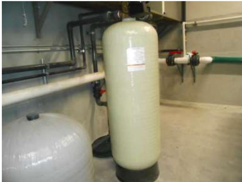
Figura 46 Filtro de carbón activado 21x62”.
