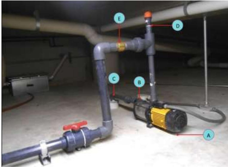
(A) Bomba, (B) tornillo para purgar, (C) Columna de succión, (D) Válvula de aire y (E) válvula check.
