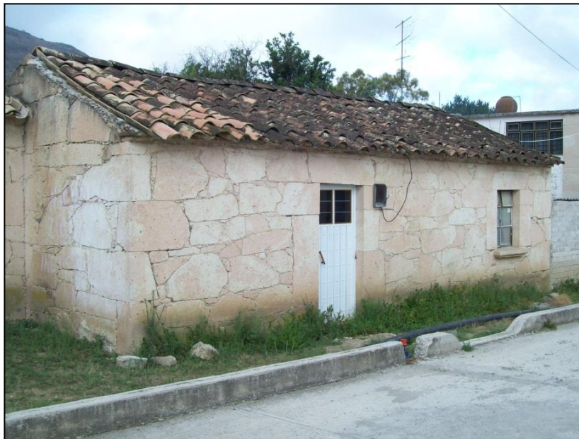
Figura 19. Aspecto de una casa típica de cantera
