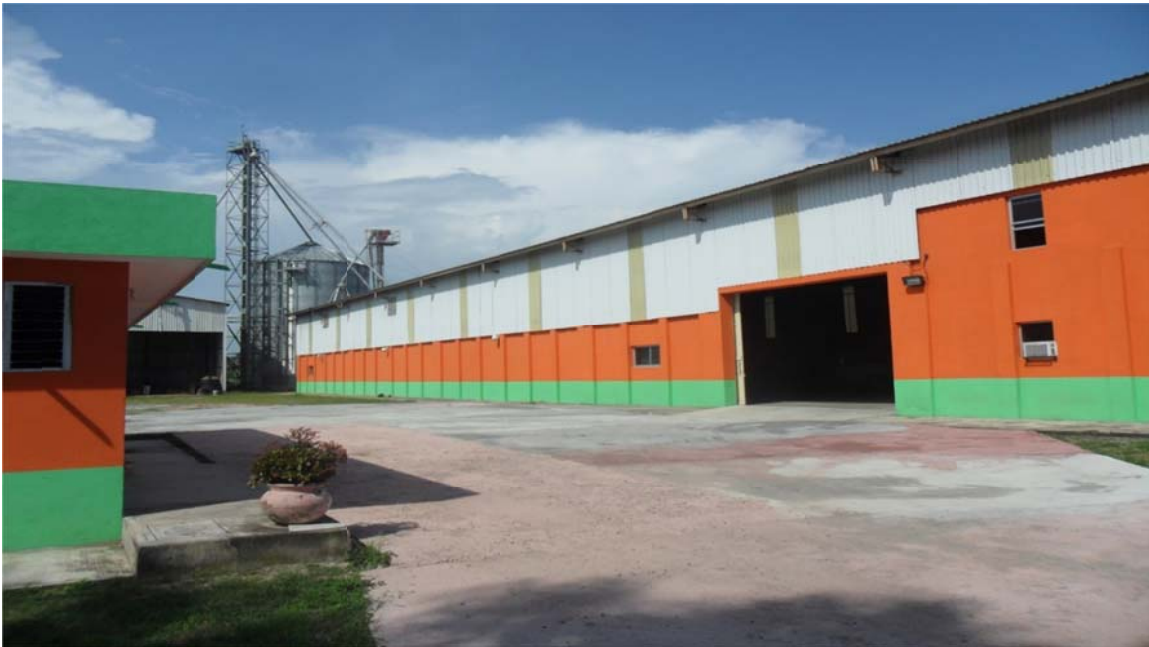
Imagen 8. Vista lateral de las instalaciones de la Organización Nutrición Animal del Soconusco, S.P.R. de R.L.
