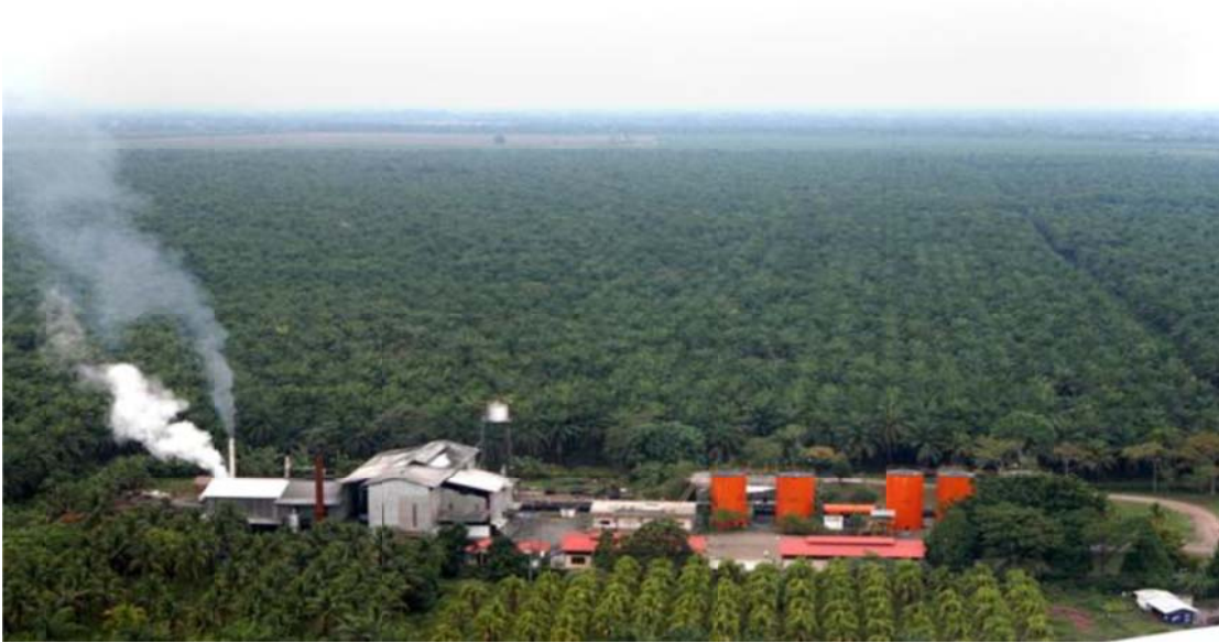
Imagen 5. Vista aérea de la planta extractora de Aceite de Palma Africana en el municipio de Acapetahua
