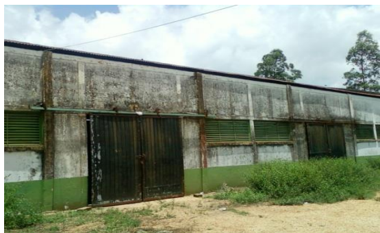
Fotografía 27. Bodega de almacenamiento de Tasiste.
