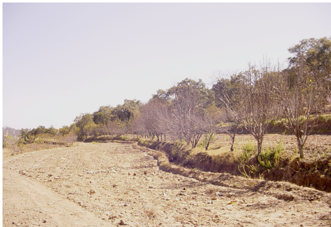
Figura 5.23. Zanjas de absorción construidas a nivel en Vicente Guerrero.
