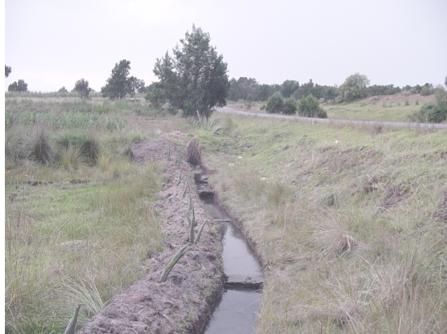
Figura 5.24. Zanja de desviación en La Reforma.
